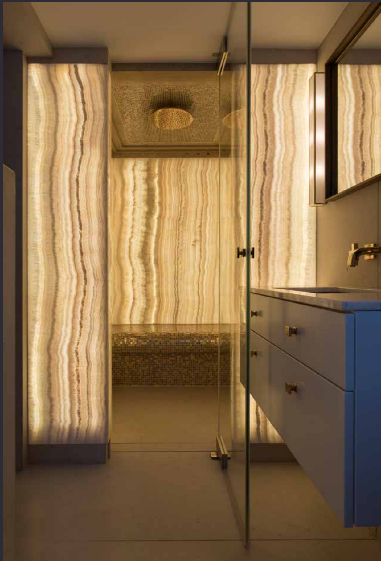
De douchewanden zijn gemaakt van verlicht onyx. De vloer is vervaardigd van Duits limestone.
